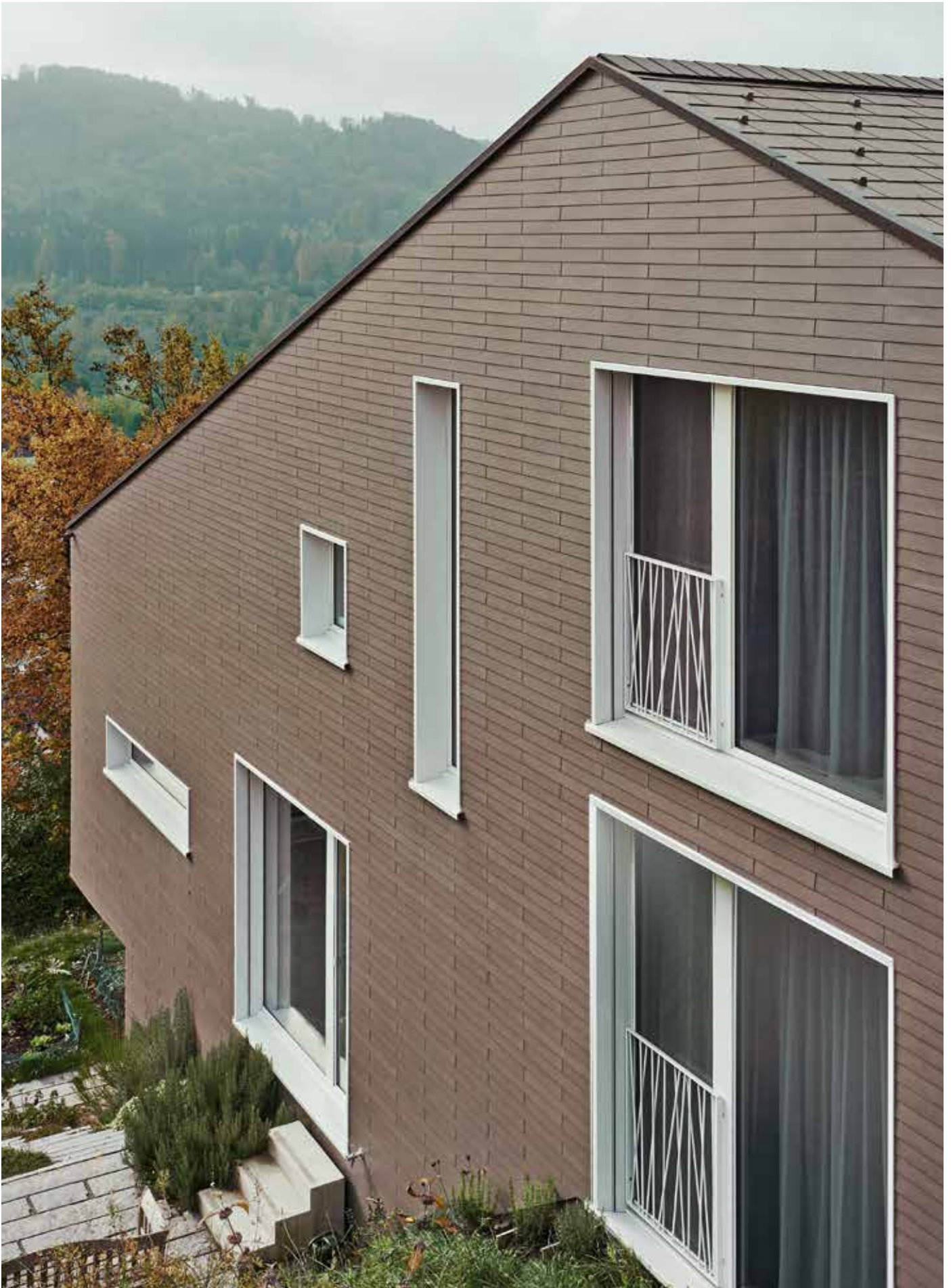
Einfamilienhaus, Dättikon/Schweiz, Architektur: Weiss und Schmid Architekten, Winterthur
