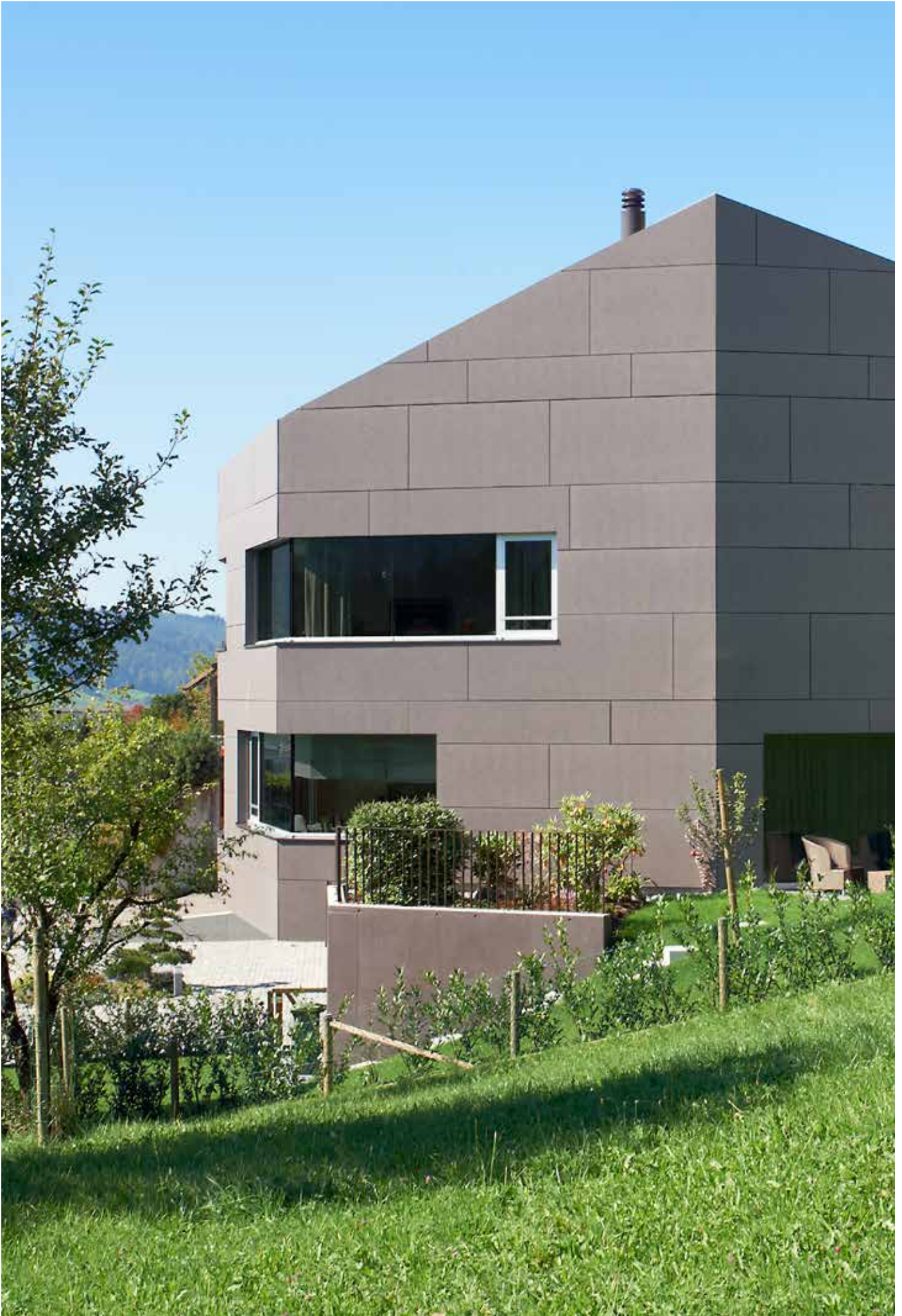
Einfamilienhaus, Oberägeri/Schweiz, Architektur: CST Architekten AG, Zug
