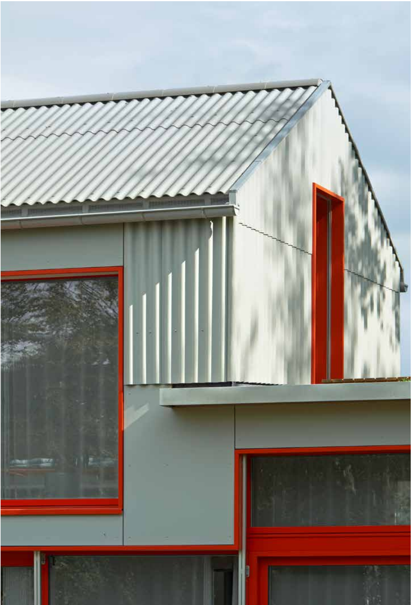
Mehrfamilienhaus, Andelfingen/Schweiz, Architektur: Robert Schaub AG, 8450 Andelfingen
